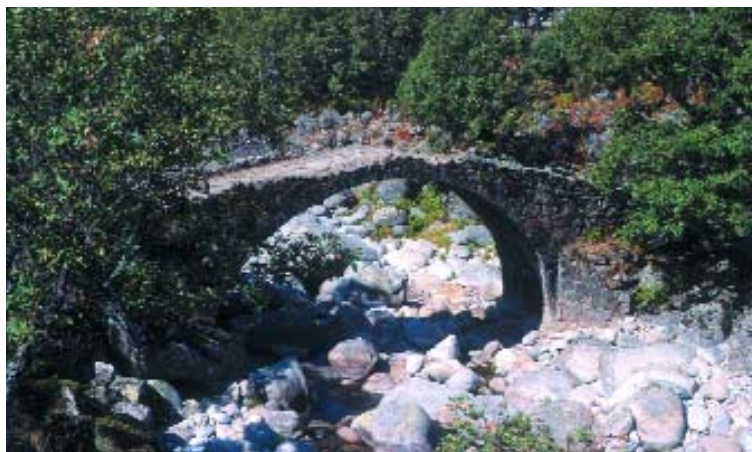
La "puente" del Puerto.
