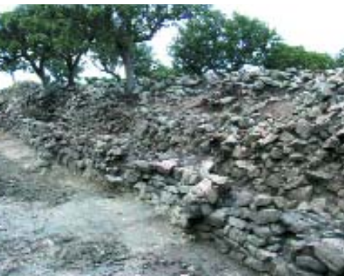
Lienzo sur del primer recinto antes de la restauración.
