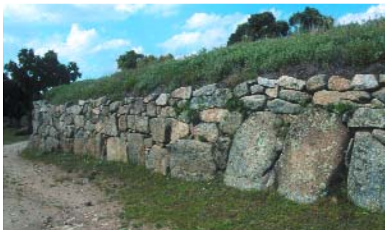
Muralla ciclópea del tercer recinto.
