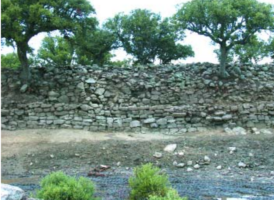
Lienzo sur del primer recinto antes de su restauración.
