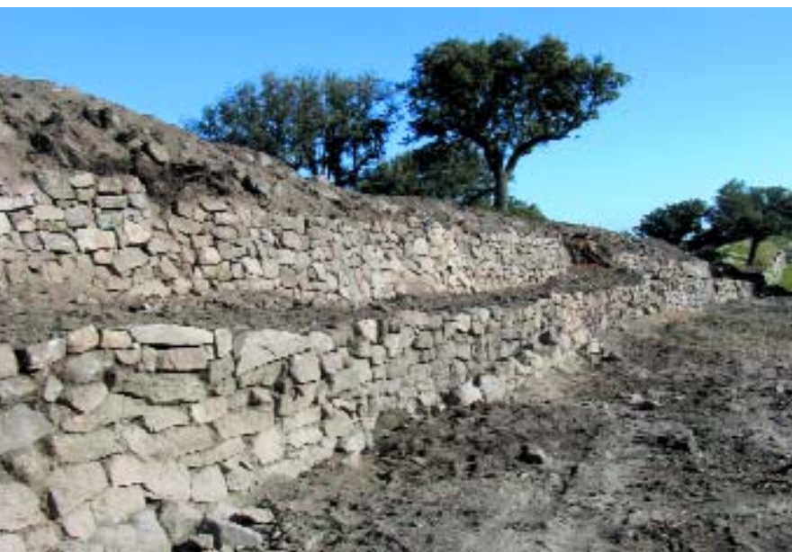
Lienzo sur del primer recinto restaurado.
